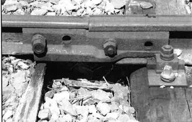
L'éclisse de transition : à droite la partie restaurée vers Dorinne-Durnal, à gauche tout reste à faire vers Evrehailles-Bauche.
